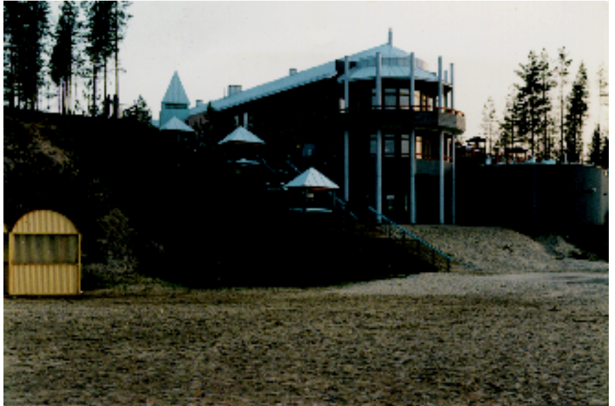
Leirin päärakennuksena toiminut hotelli
